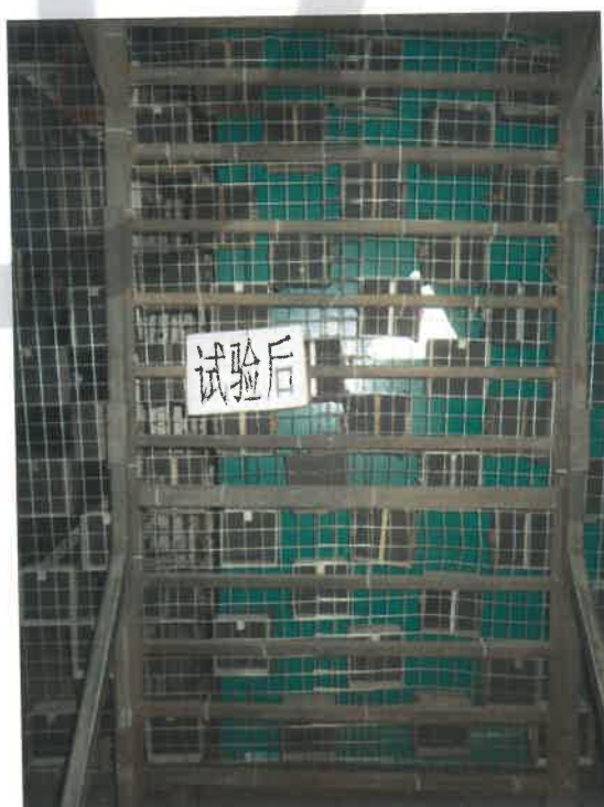
开关室试验后 侧面 2
