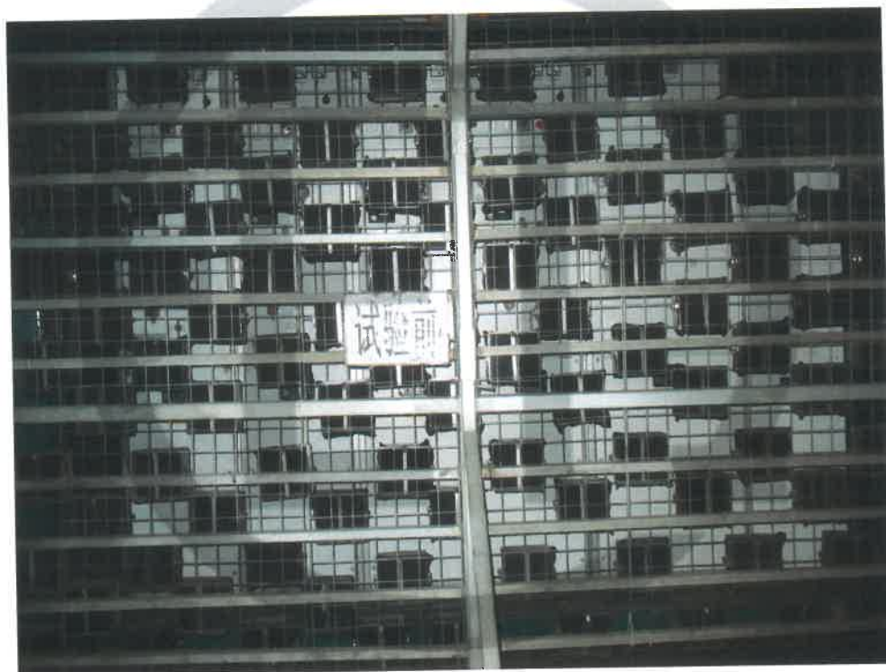
电缆室试验前 正面
